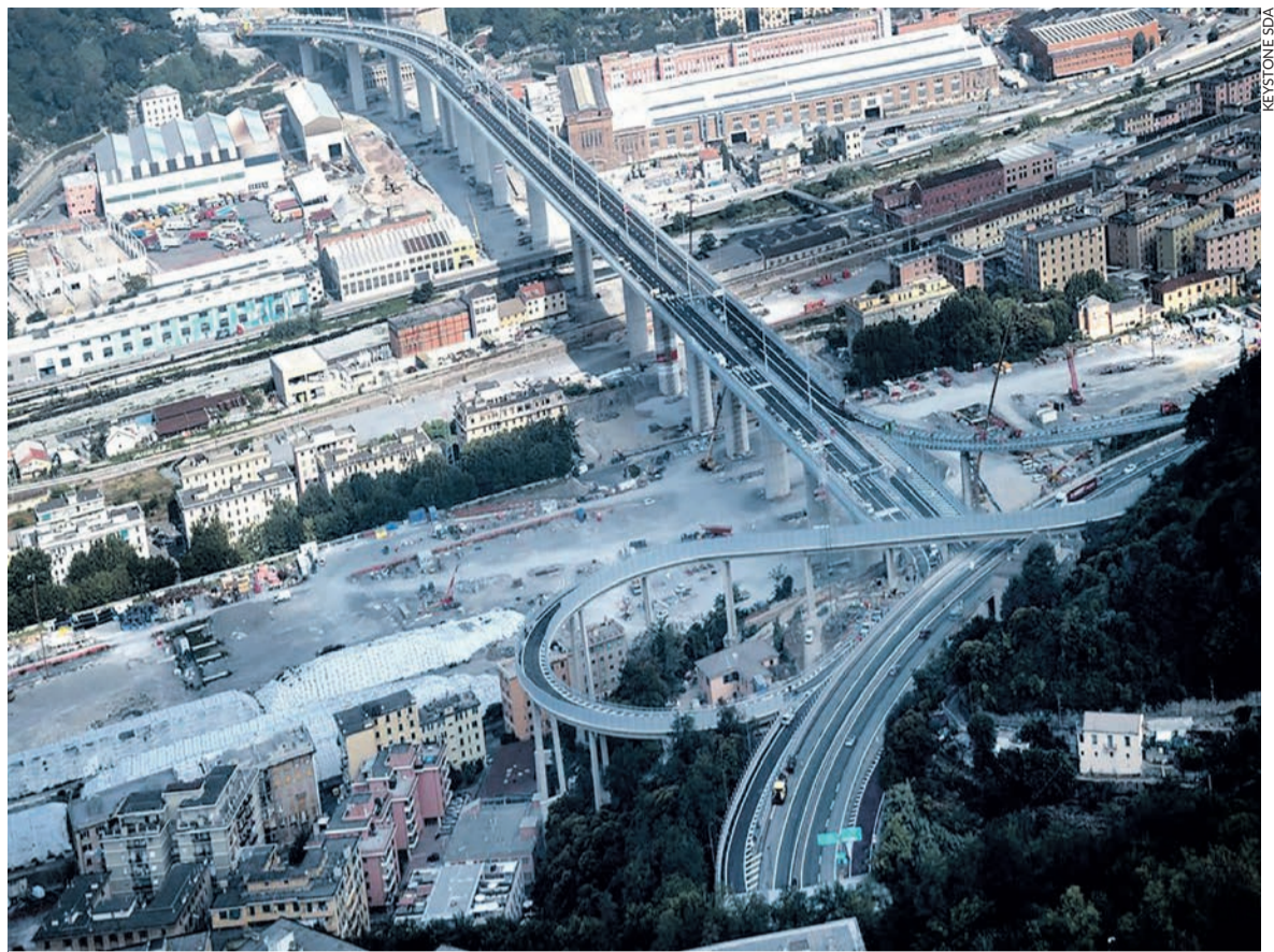
Le nouveau pont et l'échangeur qui y conduit.
