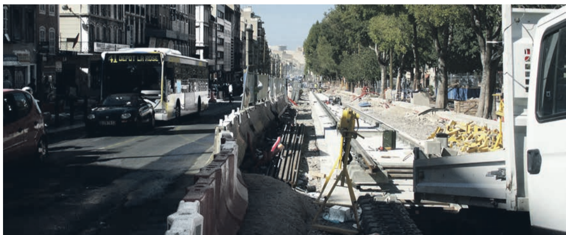
La construction du tramway sur la Canebière en 2016.
