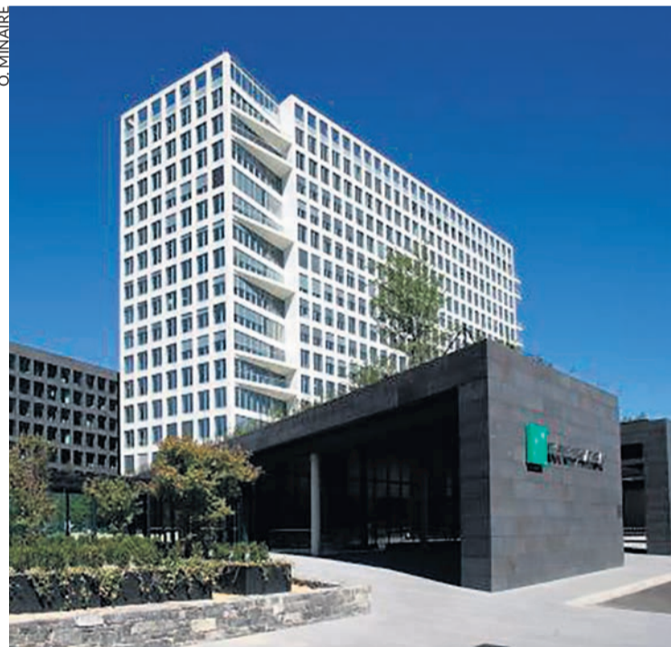
Locaux de BNP Paribas à Luxembourg, quartier du Kirchberg.
