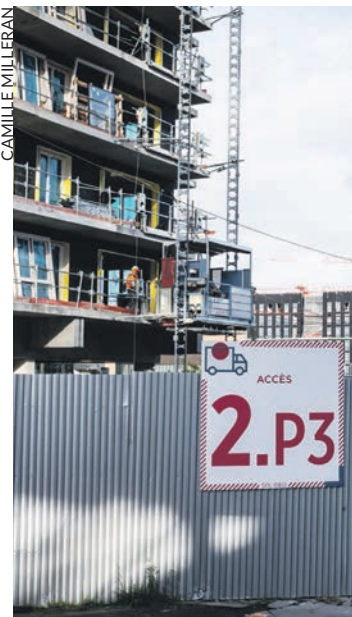
Chantier du village olympique.
