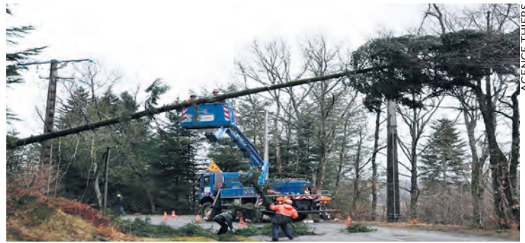
Intervention d'Enedis après une chute d'arbre.
