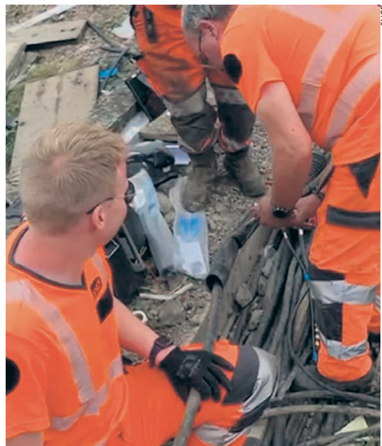
Des cheminots réparent les câbles endommagés.
