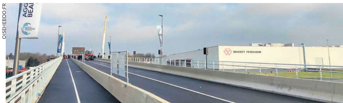
Le nouveau pont routier payé par les pouvoirs publics.
