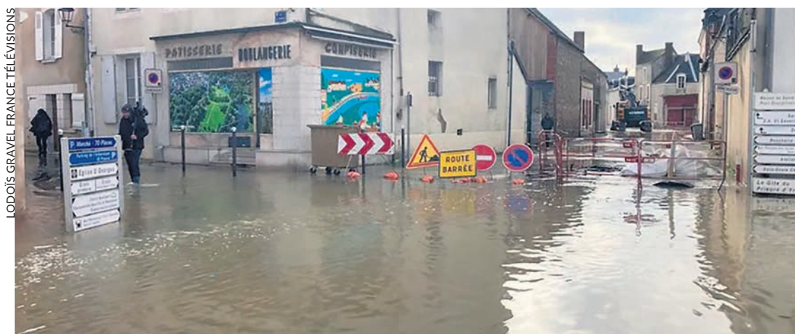
Inondation à Cloyes-les-Trois-Rivières en Eure-et-Loir.
