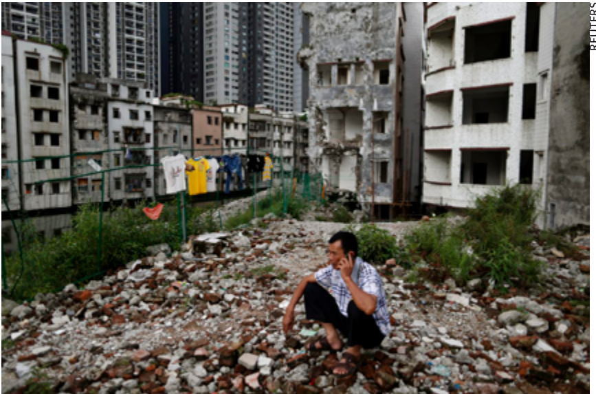
Un habitant d'immeuble délabré, en bordure du centre-ville moderne de Guangzhou (Canton).
