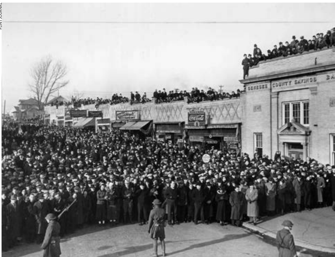
La foule venue soutenir les grévistes qui occupent les usines General Motors à Flint, dans le Michigan, aux États-Unis, en 1936-1937.
