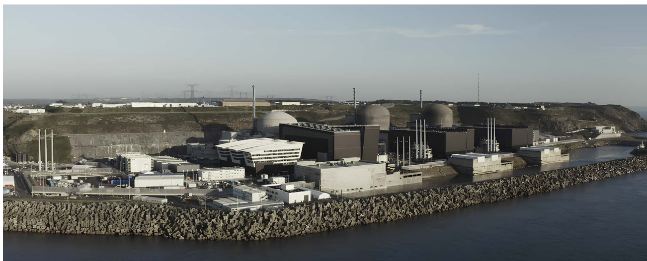
La centrale de Flamanville sur la côte du Cotentin, près de Cherbourg, avec le réacteur EPR, en 2023.
