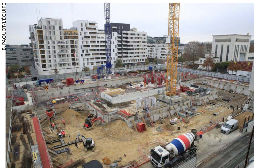
Le chantier du village olympique à Paris, où les donneurs d'ordre ont organisé une sous-traitance en cascade, ici en novembre 2021.
